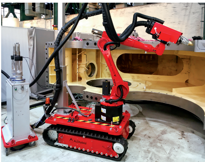
Die Reparatur der Lagersitze, bei dem der größte Lagersitz einen Durchmesser von 1,7 Meter erreichte, erfolgte mittels Laserauftragschweißen mit Pulver.
